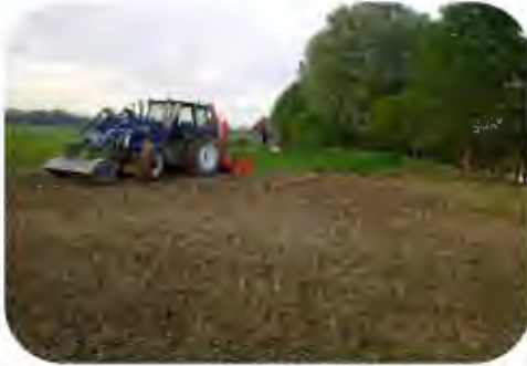
Radovi na infrastrukturi – protupoplavni platoi
